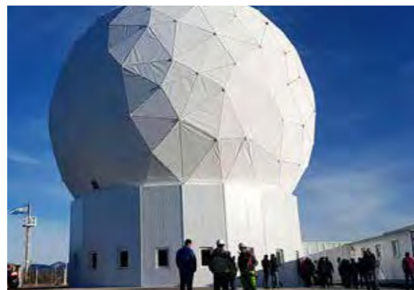
Estación Terrena Tierra del Fuego
