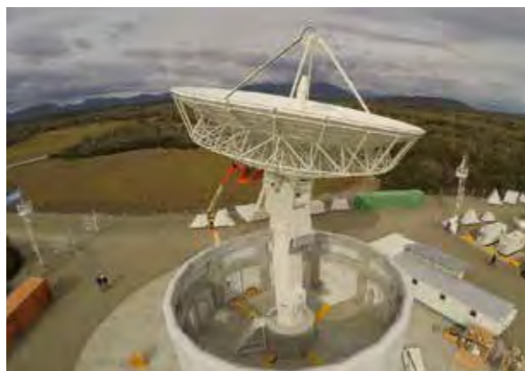
Estación Terrena Tierra del Fuego
