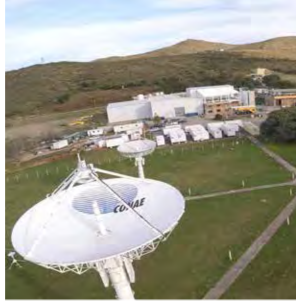
Estación Terrena Córdoba
